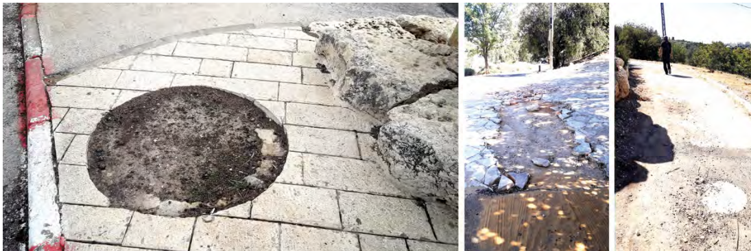
תמונה 32 : שבילים סדוקים, היעדר אבנים משתלבות וערוגות עצים בטיילת הר הצופים
