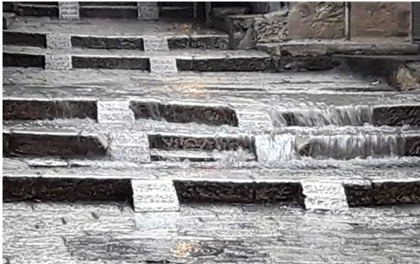
תמונה 18: בעיות ניקוז במורדות רחוב שער השלשלת
